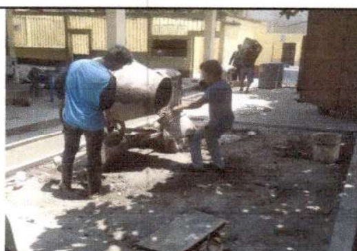
Foto 4: Repello de paredes.
