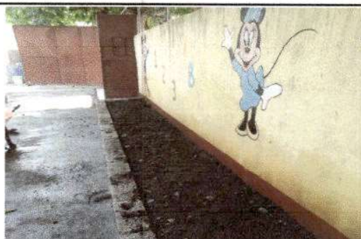
Foto 6: Sustitución de banqueta.
