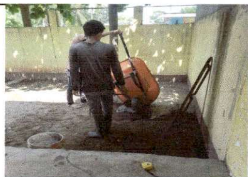
Foto 3: Sustitución de torta de cemento
